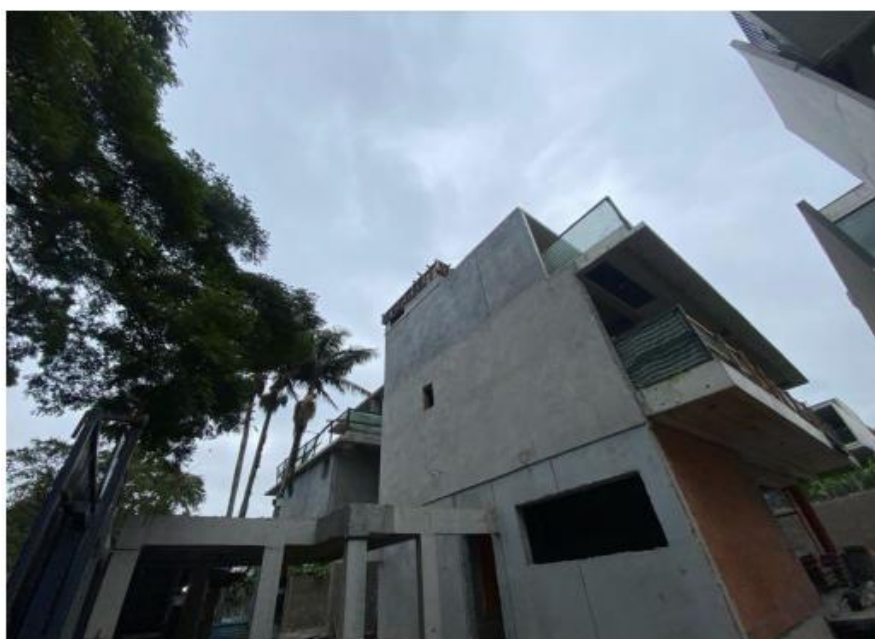
Emboço da Fachada
