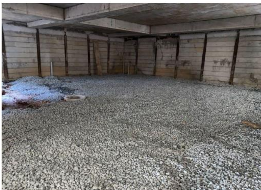
Preparo do substrato para piso do subsolo
