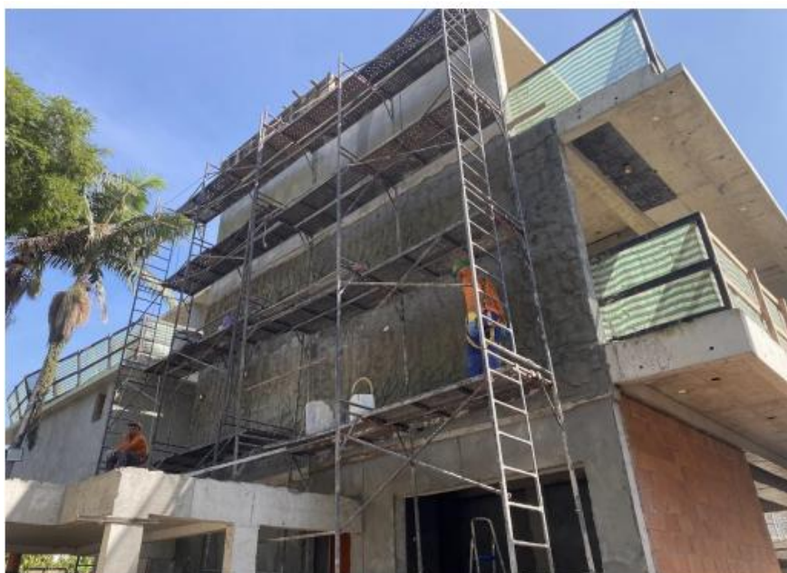
Emboço da Fachada
