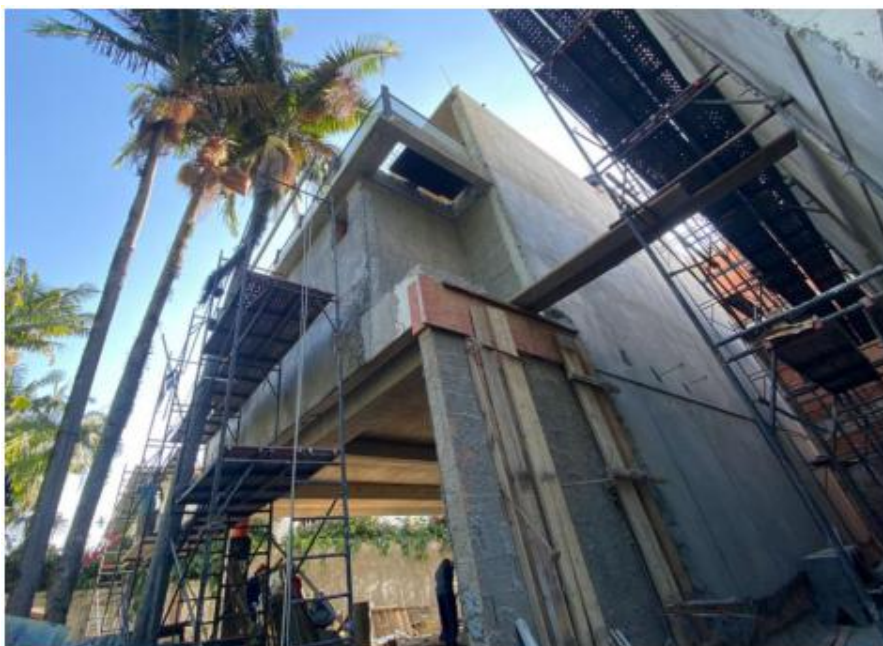
Emboço da Fachada
