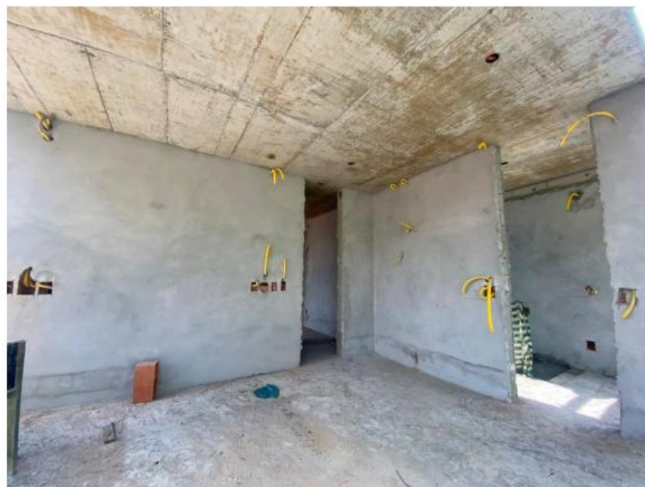
Instalação de caixinha de elétrica e emboço Casa 2
