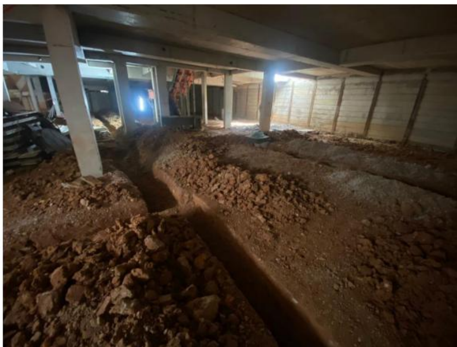
Abertura de valas de hidráulica subsolo
