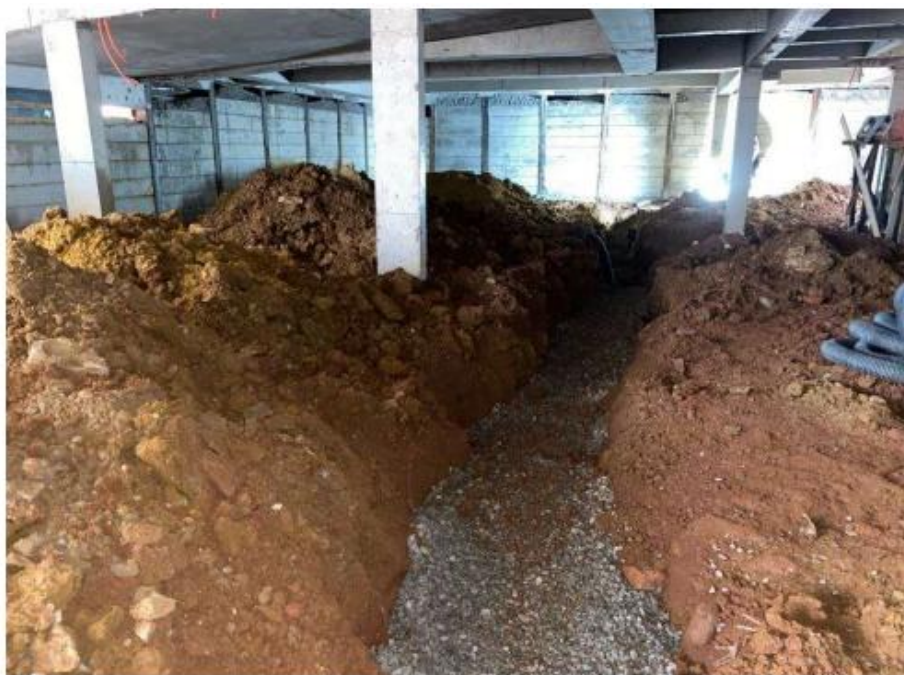
Movimentação de terra do subsolo
